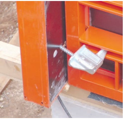
Dettaglio tirante a gancio per pilastro
