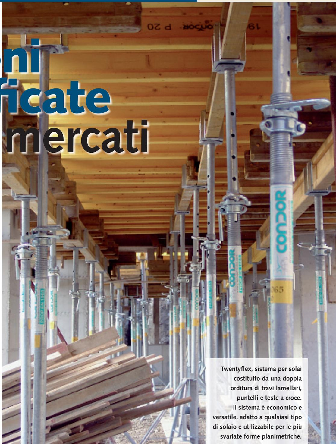
Twentyflex, sistema per solai costituito da una doppia orditura di travi lamellari, puntelli e teste a croce. Il sistema è economico e versatile, adatto a qualsiasi tipo di solaio e utilizzabile per le più svariate forme planimetriche.
