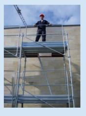
Una volta completato il montaggio di parapetti di testa e facciata, tavole e fermapiede è possibile accedere al piano superiore, che risulta già utilizzabile in condizioni di sicurezza per l'elevazione del piano successivo.
