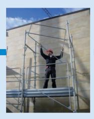
Una volta installate basette e telai di partenza, l'operatore può procedere all'inserimento del gancio sagomato superiore del parapetto alla boccola superiore del telaio, ruotando il parapetto verso l'alto per allinearlo al secondo punto di aggancio.
