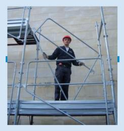
Elemento base del sistema Risk Free è il parapetto triangolare a tre punti di attacco, che consente il montaggio del piano superiore del ponteggio rimanendo al piano inferiore in posizione perfettamente riparata contro le cadute.
