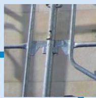
Una volta agganciato il parapetto al secondo punto di aggancio del telaio, è possibile innestare anche il perno inferiore del parapetto alla boccola inferiore del telaio e far scendere la spina di sicurezza per fissarlo.
