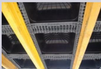
Skydome è il sistema Geoplast di casseforme modulari in plastica rigenerata progettato per la realizzazione di solai bidirezionali alleggeriti ad uso civile e commerciale.
